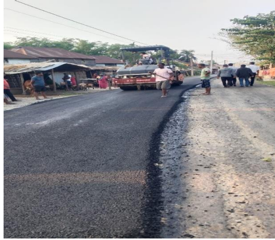
सडक निर्माण कार्य
