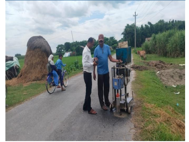
सडक निर्माण कार्य
