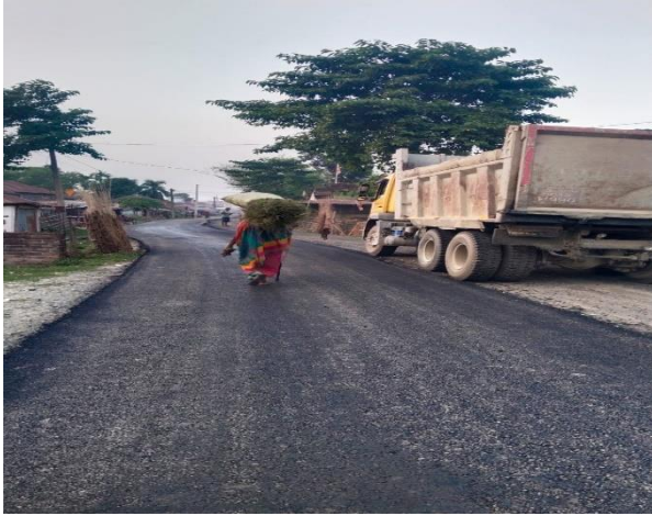
सडक निर्माण कार्य
