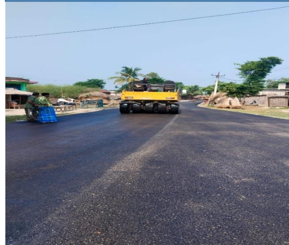
सडक निर्माण कार्य
