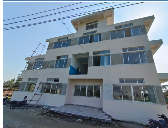
१५ शैयाको आधारभूत अस्पताल भवन निर्माण कार्य
