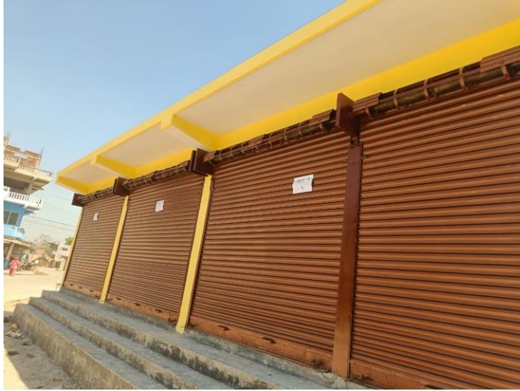
हरिनगर गा.पा. ६ घुस्की बजारमा सुपरमार्केट भवन निर्माण कार्य
